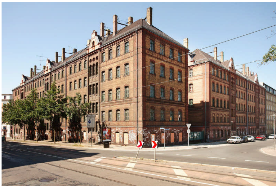
Ansicht Reibeckstrasse, Ecke Eilenburger Strasse
