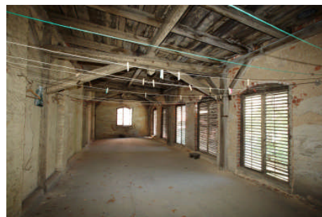
Dachgeschoss, noch nicht ausgebaut
