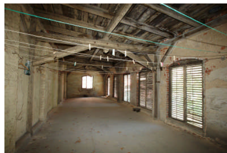
Dachgeschoss, noch nicht ausgebaut
