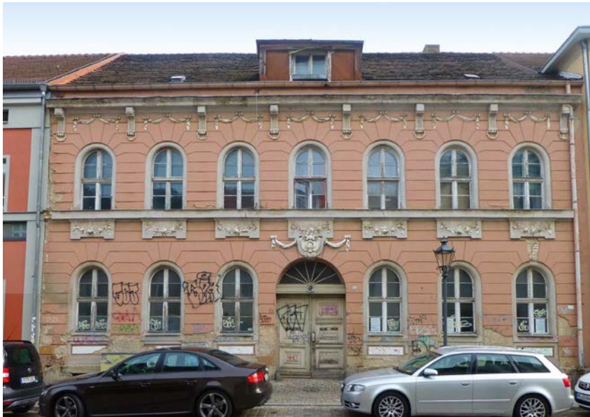
Altbau vor der Sanierung
