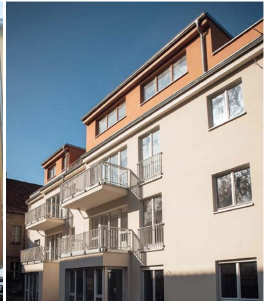
Neubau in den letzten Zügen
